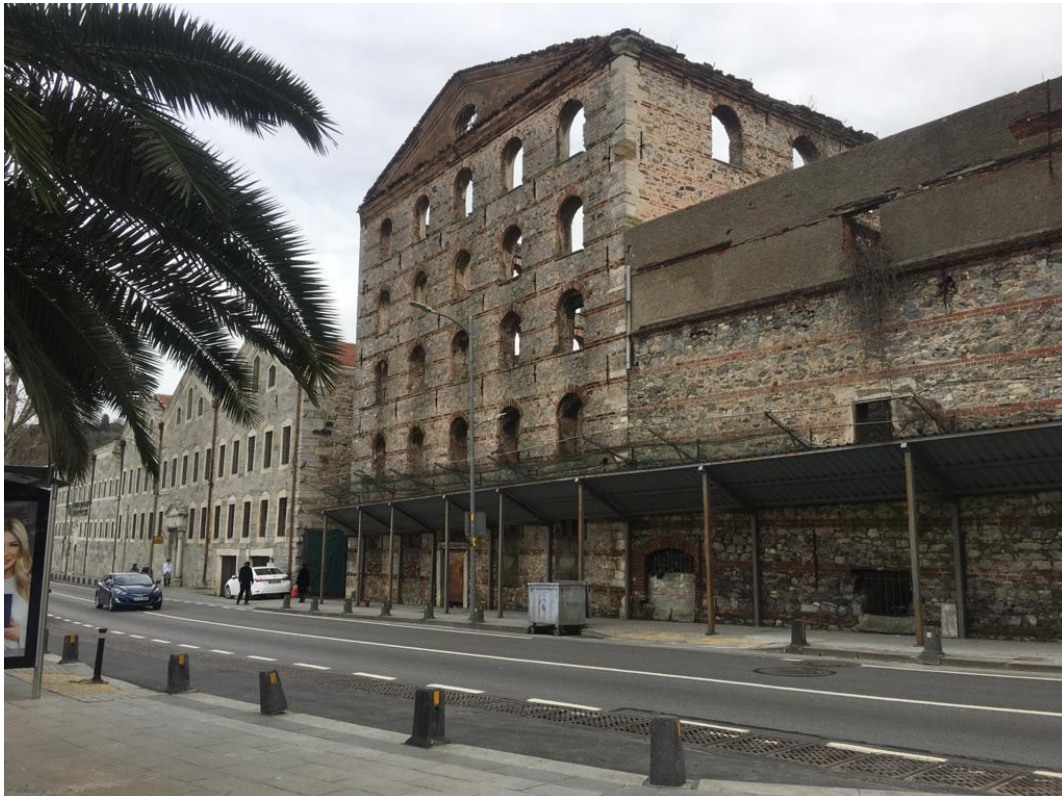
Image 2: Paşalimanı Un Fabrikası (Url-2)
